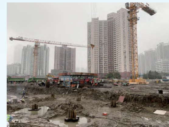
2020.3月首道土方开挖
