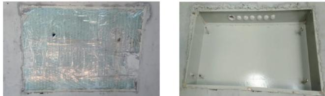
③在剪力墙、柱内安装线盒时,加强线盒模筋的焊接,提高线盒的贴墙率,以及线盒方正率,减少以后修补量和剔凿量,同时要加强对线盒标高的控制,做到每个线盒的标高均通过红外线水平仪定位。土建拆模后及时清理线盒以及填塞线盒专用聚苯板(此方法比传统做法节省人工),以防墙面喷浆时污染线盒。
