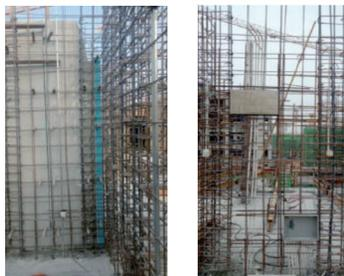
②如有可能提前采购到配电箱壳,尽可能采用成熟的《剪力墙内配电箱一次成型工法》,把配电箱壳在剪力墙中一次性的预埋到位,这样能为以后安装节约大量的人工和材料成本。成型效果如下图所示:
