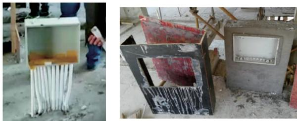
二次结构上强电箱(户箱),一般安装高度为1.8米,现场安装也可采取一定的方法来减少后期的安装人工成本,此方法工地上正在安排工人进行施工人工、材料用量对比,初步觉得能够节约部分人工。不过此方法需要土建施工时配合,如下图所示(吊装的C型钢可重复利用):
