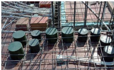
2、提前深化设计图纸,确定各类管道走向位置,制作预埋定位模板,在结构施工时直接预埋安装卫生间管道吊杆的预埋件,与结构混凝土一起浇筑,排水管下料、安装统一尺寸,力争高层建筑实现无电源装配式施工。如右图示意(照片中星形中为在模板上预埋的螺杆,与现浇板砼一起浇筑)。
