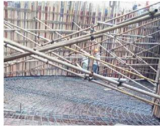
要保证墙面的平整度，必须保证墙面尺寸、垂直度和模板接缝质量。在圆筒墙钢筋上设置顶横棍，间距1200mm梅花布置，其根部须在模板安装前加焊Φ14钢筋限位，以确保墙位置和截面尺寸正确。模板接缝间加密封胶条，防止漏浆。模板支设完成后统一进行垂直度检查，必须达到规范要求，最后模板斜撑和水平撑和对拉螺栓加固到位。
