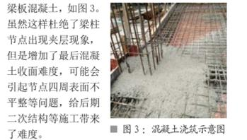
混凝土，如图3。虽然这样杜绝了梁柱节点出现夹层现象，但是增加了最后混凝土收面难度，可能会引起节点四周表面不平整等问题，给后期二次结构等施工带来了难度。
