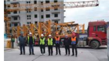
塔吊拆卸项目负责人带班交底
