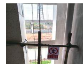
整改后防护栏杆恢复到位
