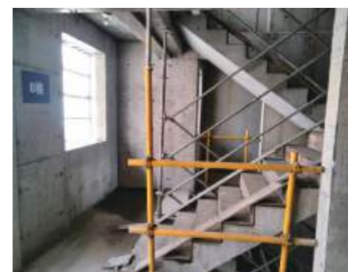
临边防护搭设完好
