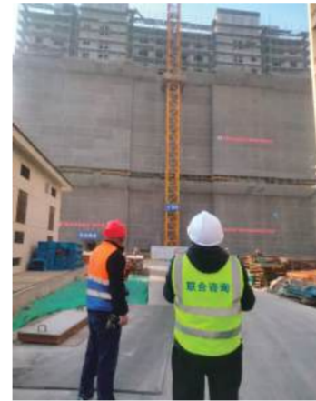
脚手架拆卸专人全程监管
