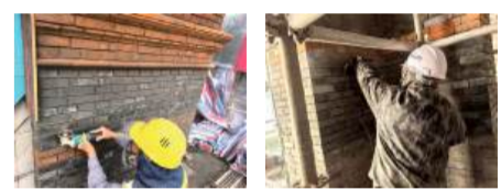
墙体灰缝二次修整
