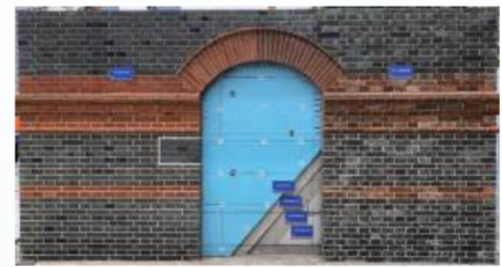
清水墙样板施工
